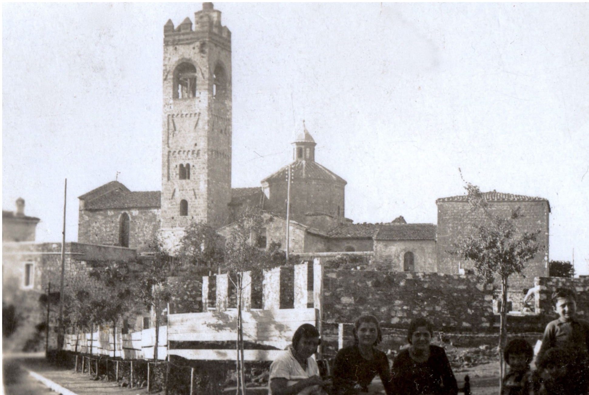
1936 - Casa del Fascio in costruzione, vista dal sobborgo di Prato.
