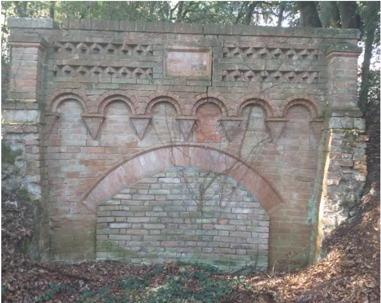
Passaggio sotterraneo nel bosco dietro la Villa Marri Mignanelli
