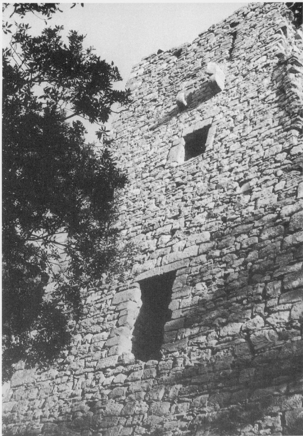
Torre di Montalceto, lato ovest - abbastanza ben conservato presenta a differenza degli altri tre lati la finestra in alto non tamponata, con evidente i fori di inserimento delle inferiate. Al di sopra di essa i resti di due mensole ed al di sotto una ampia apertura
